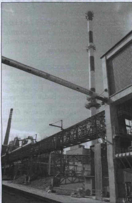
Pierwszy w polskim koksownictwie stalowy komin ze stałą analizą spalin.
