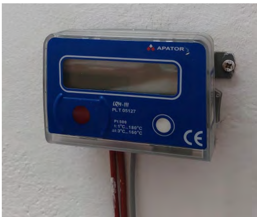
Zdjęcie nr 10 (Budynek nr 5)
