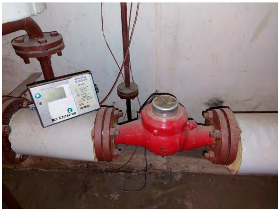
Zdjęcie nr 11 (Budynek nr 4)
