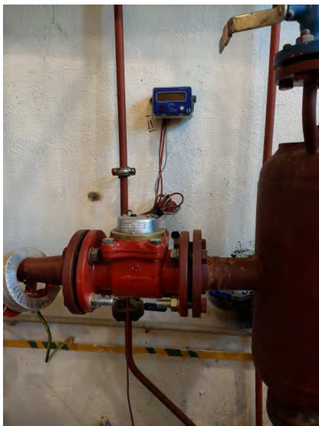
Zdjęcie nr 8 (Budynek nr 6)
