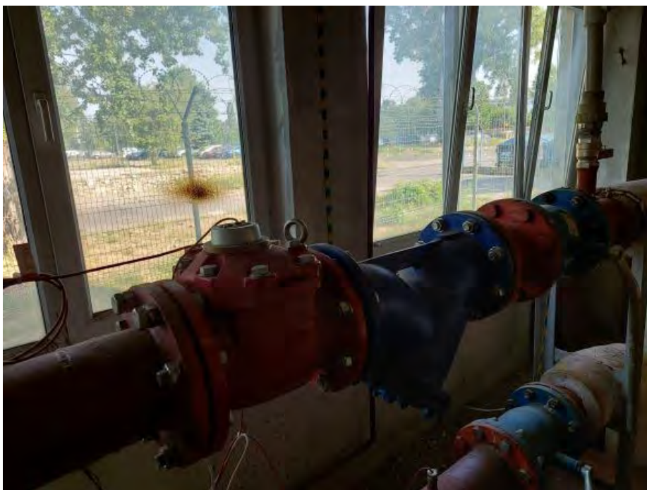
Zdjęcie nr 7 (Budynek nr 20)
