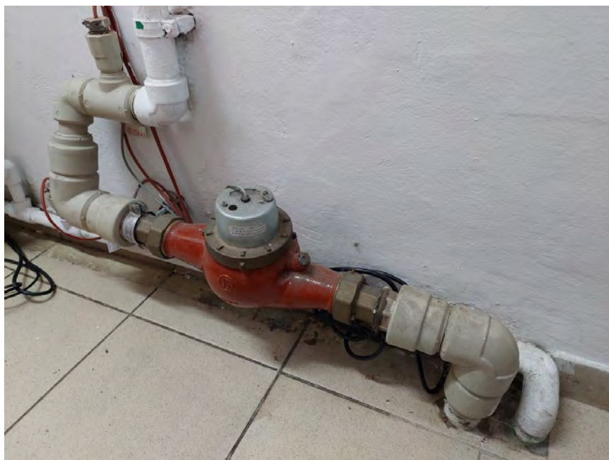
Zdjęcie nr 9 (Budynek nr 5)
