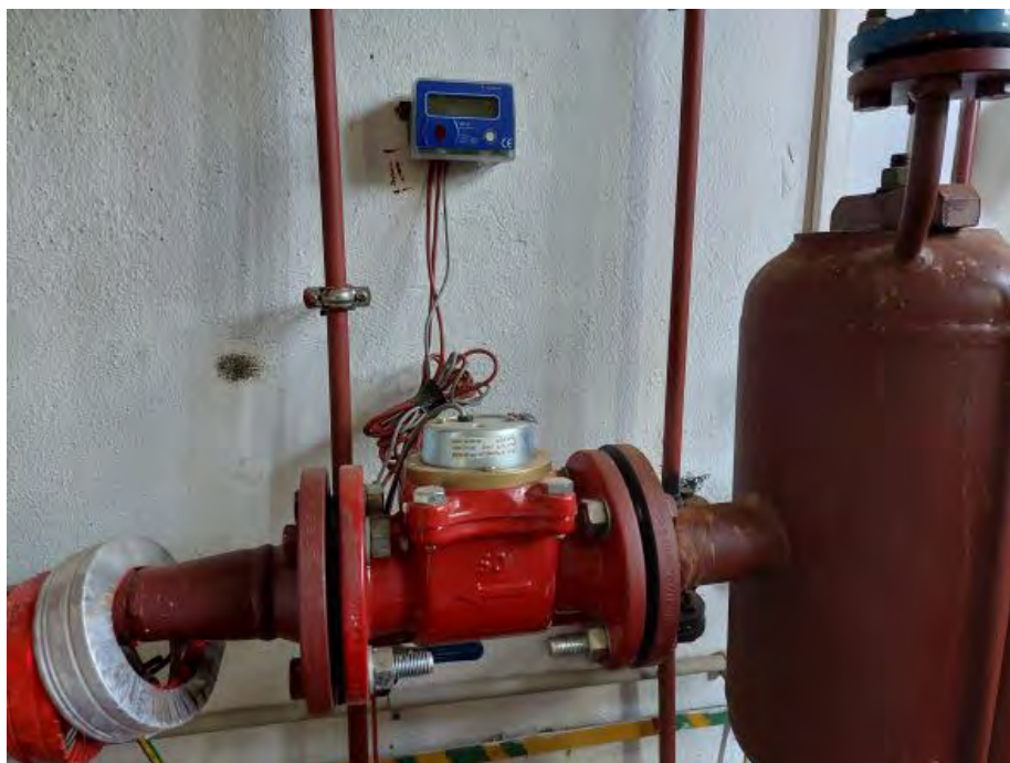
Zdjęcie nr 13 (Budynek nr 2)
