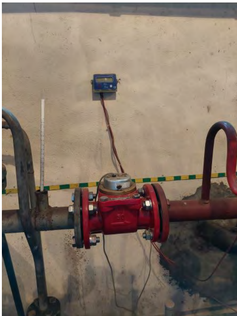
Zdjęcie nr 12 (Budynek nr 3)
