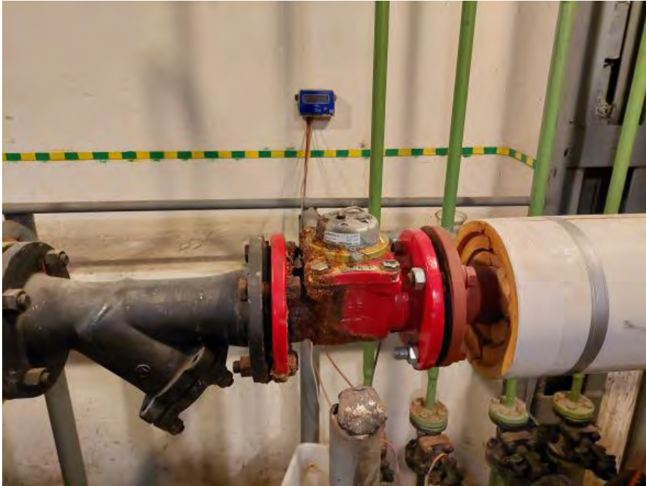
Zdjęcie nr 1 (Budynek nr 25)
