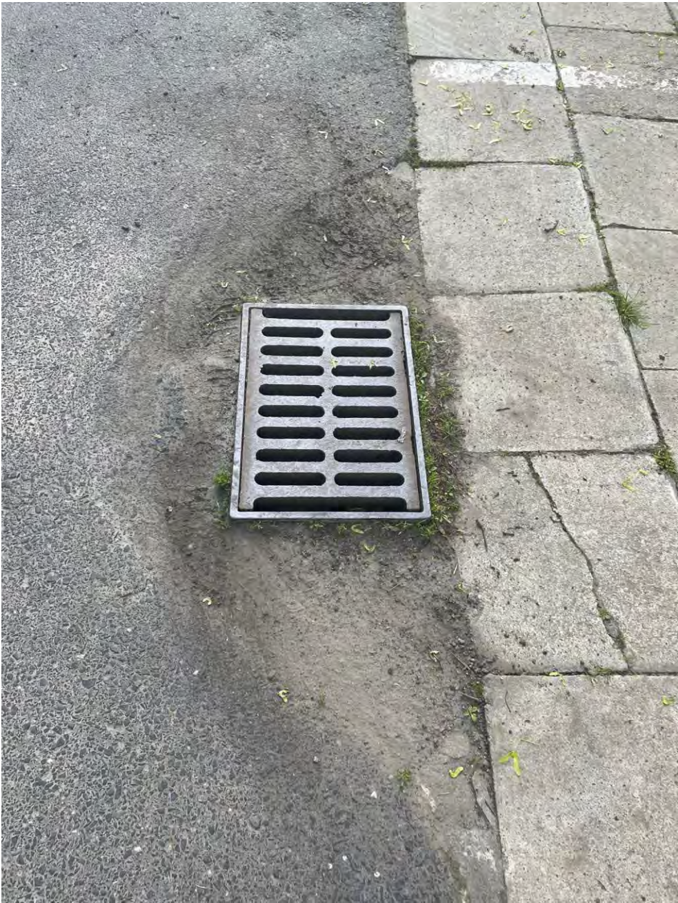
Załącznik graficzny nr 1– studzienka kanalizacji deszczowej do ponownego obsadzenia po uprzednim wykonaniu właściwych spadków nawierzchni i wykonaniu łączenia z krawężnikiem ulicznym ułożonym na płask – detal rysunek nr 1.
