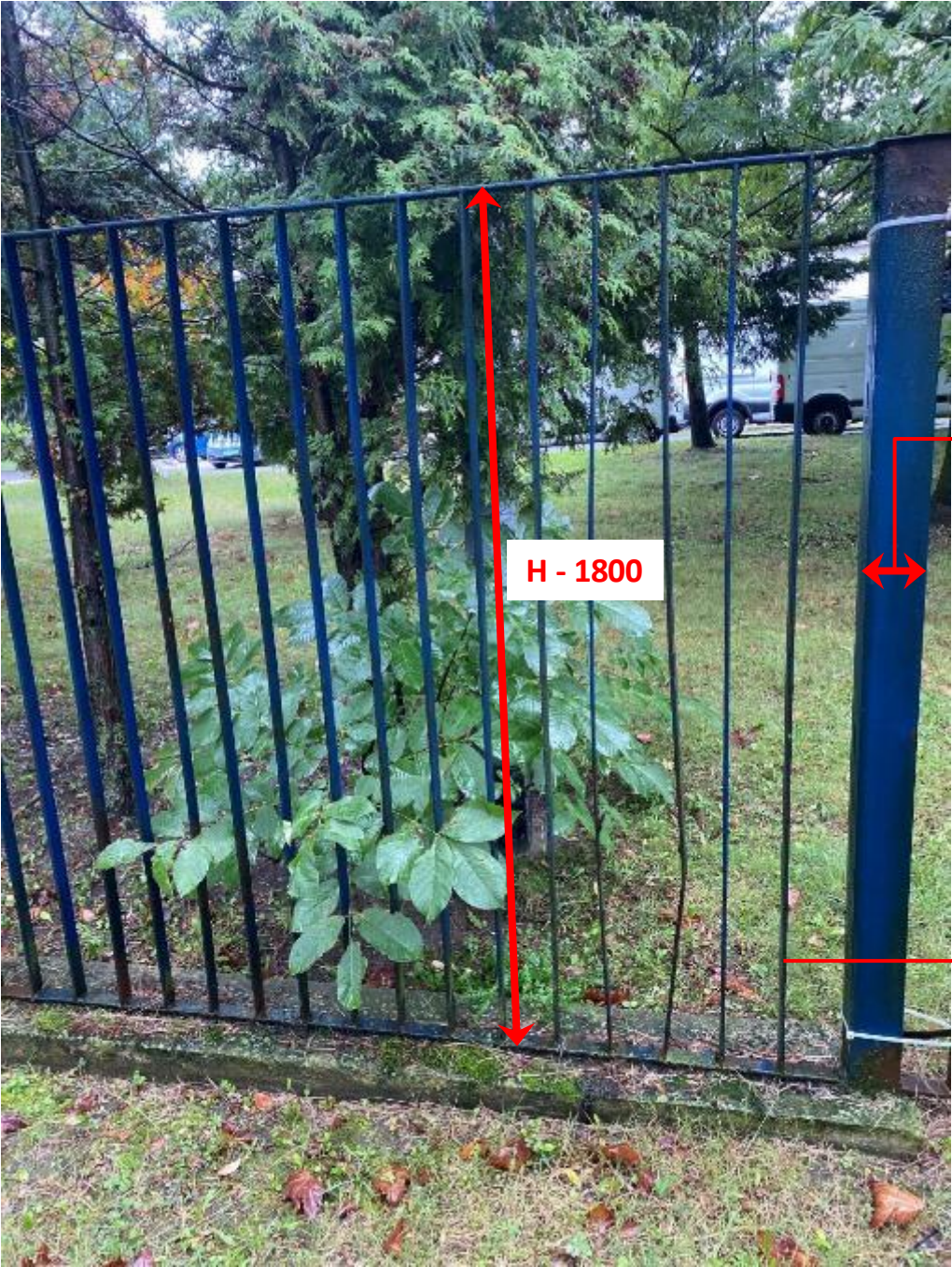
Załącznik graficzny nr 1 – Miejsce prowadzenia prac remontowych oraz przykładowe zdjęcia segmentów (przęseł) ogrodzenia w tym wymagających prostowania i spawanie elementów.
