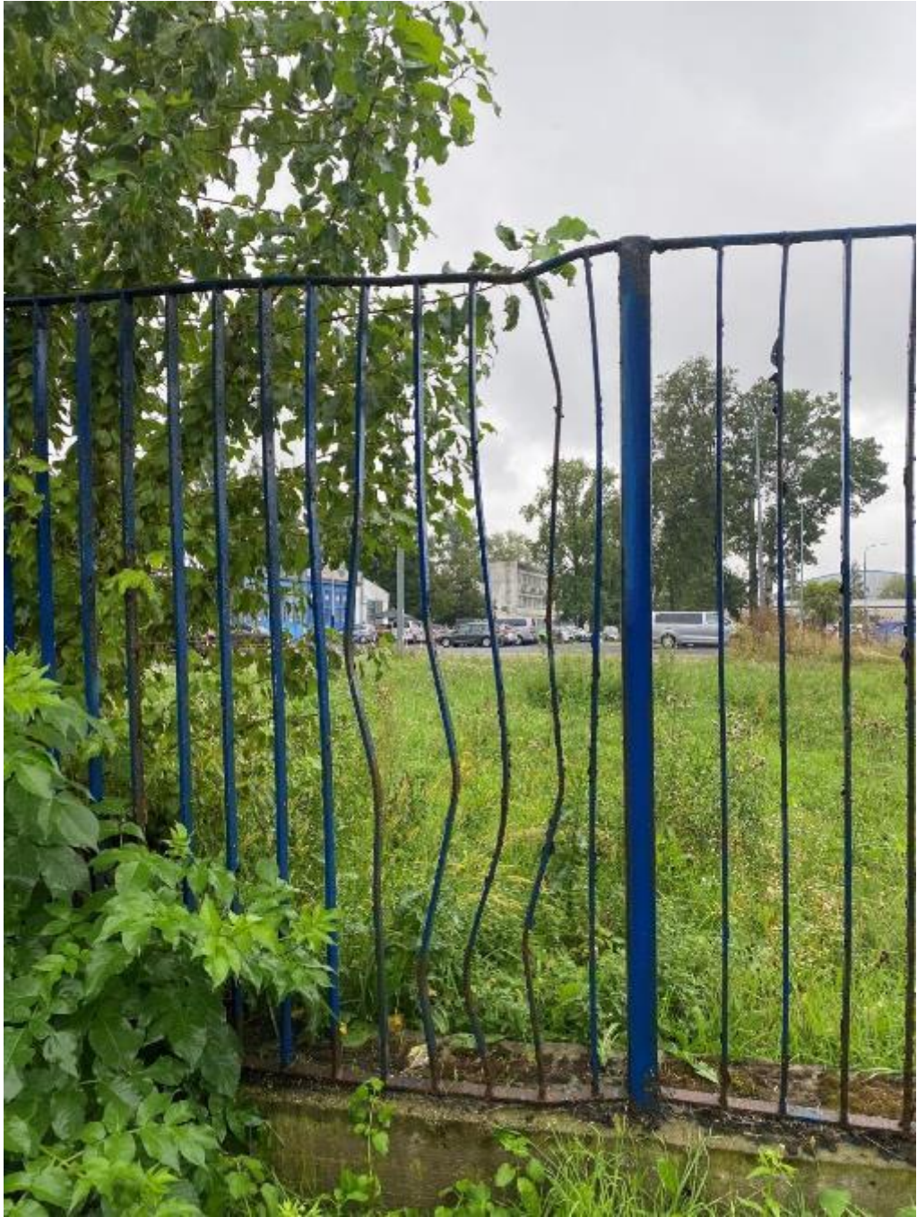
Załącznik graficzny nr 1 – Miejsce prowadzenia prac remontowych oraz przykładowe zdjęcia segmentów (przęseł) ogrodzenia w tym wymagających prostowania i spawanie elementów.
