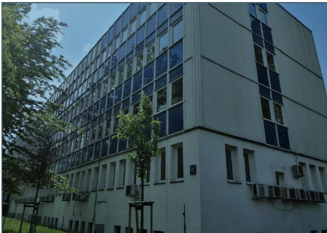
Zdjęcie nr 1. Poglądowe zdjęcie elewacji budynku – widok od strony drogi wewnętrznej.
