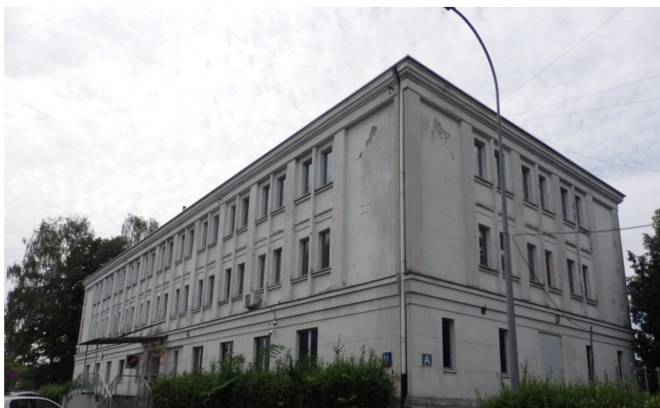
Zdjęcie nr 1. Poglądowe zdjęcie elewacji budynku – widok od strony drogi wewnętrznej.
